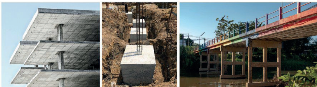
ก. พื้นอาคาร
