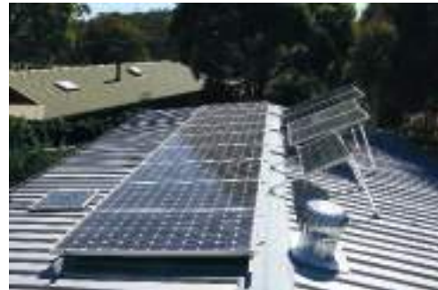
ฉ. หลังคาของอาคารต่าง ๆ
