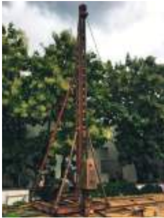
ก. การใช้ตุ้มปั้นจั่นในการตอกเสาเข็ม
