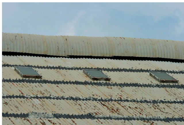
ภาพที่ 2 การผุกร่อนของหลังคาสังกะสีเมื่อทำปฏิกริยากับน้ำฝนที่มีสมบัติเป็นกรด
