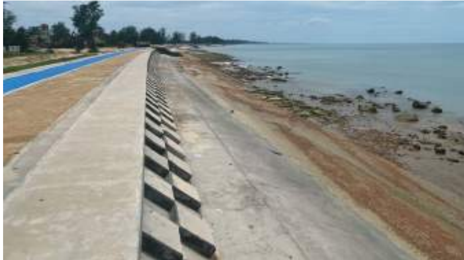
ภาพที่ 9 โครงสร้างป้องกันการกัดเซาะชายฝั่ง เชื่อมป้องกันตลิ่งริมทะเล ตำบลชิงโค อำเภอสิงหนคร จังหวัดสงขลา ที่มา : กรมทรัพยากรทางทะเลและชายฝั่ง
