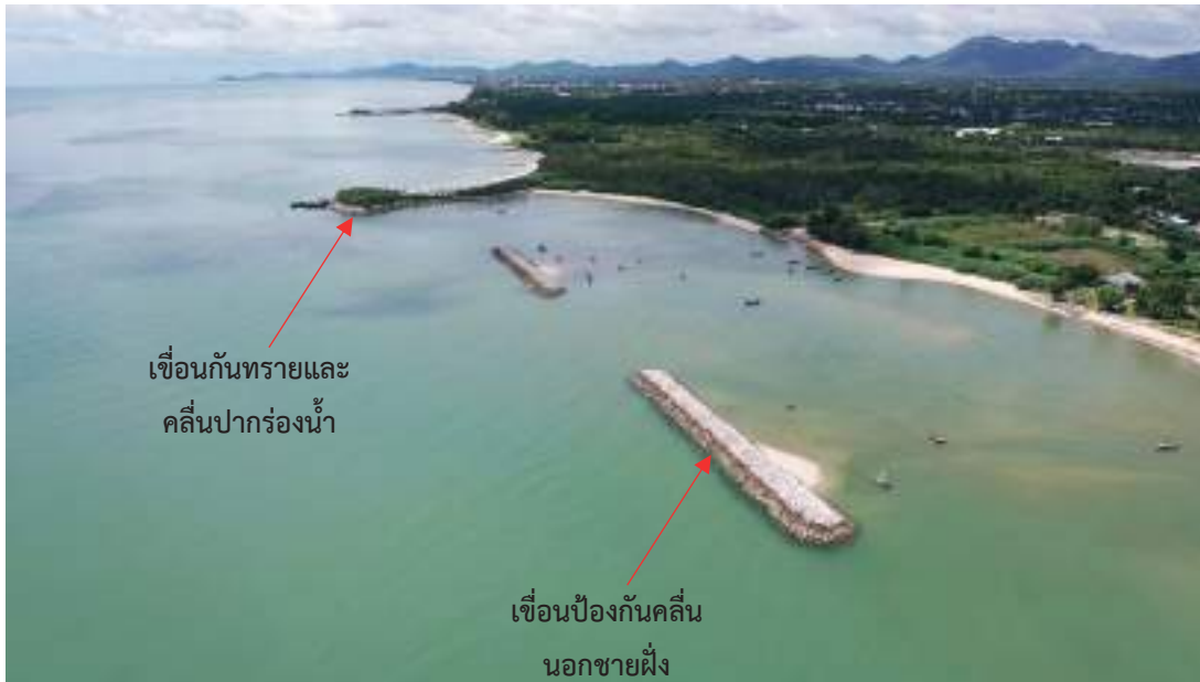
ภาพที่ 11 โครงสร้างป้องกันการกัดเซาะชายฝั่ง เขื่อนกันทรายและคลื่นปากร่องน้ำ และเขื่อนป้องกันคลื่นนอกชายฝั่ง บริเวณพระราชินีเวศน์มฤคทายวัน ตำบลชะอำ อำเภอชะอำ จังหวัดเพชรบุรี ที่มา : กรมทรัพยากรทางทะเลและชายฝั่ง
