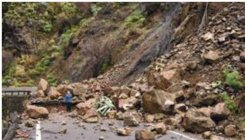
ภาพที่ 4 การถล่มลงมาของดินและหินร่วมกันตรงบริเวณที่ตลาดเชิงเขา
