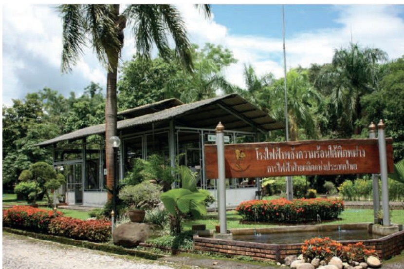
ภาพที่ 18 โรงไฟฟ้าพลังงานความร้อนใต้พิภพผาง จังหวัดเชียงใหม่
