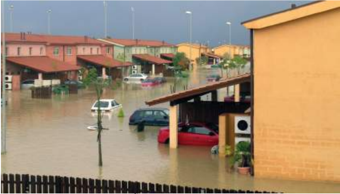
ค. น้ำท่วมขังในเขตที่พักอาศัย
