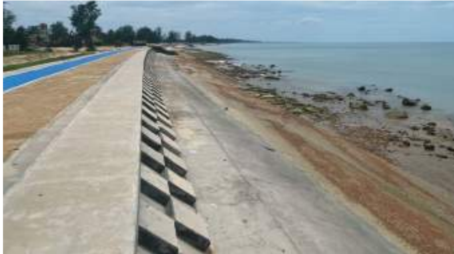
ภาพที่ 9 โครงสร้างป้องกันการกัดเซาะชายฝั่ง เชื้อนป้องกันตลิ่งริมทะเล ตำบลชิงโค อำเภอสิงหนคร จังหวัดสงขลา ที่มา : กรมทรัพยากรทางทะเลและชายฝั่ง
