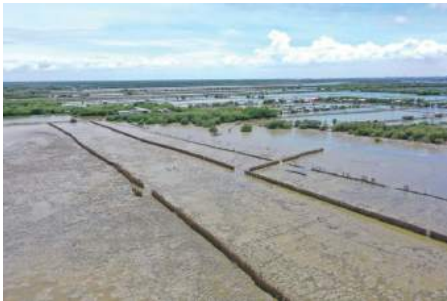
ภาพที่ 10 โครงสร้างป้องกันการกัดเซาะชายฝั่ง การปักไม้ไผ่ชะลอความรุนแรงของคลื่น บ้านขุนสมุทรจีน ตำบลแหลมฟ้าผ่า อำเภอพระสมุทรเจดีย์ จังหวัดสมุทรปราการ ที่มา : กรมทรัพยากรทางทะเลและชายฝั่ง
