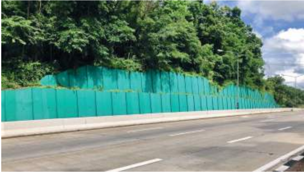
ภาพที่ 5 การทำกำแพงคอนกรีตป้องกันแผ่นดินถล่ม
