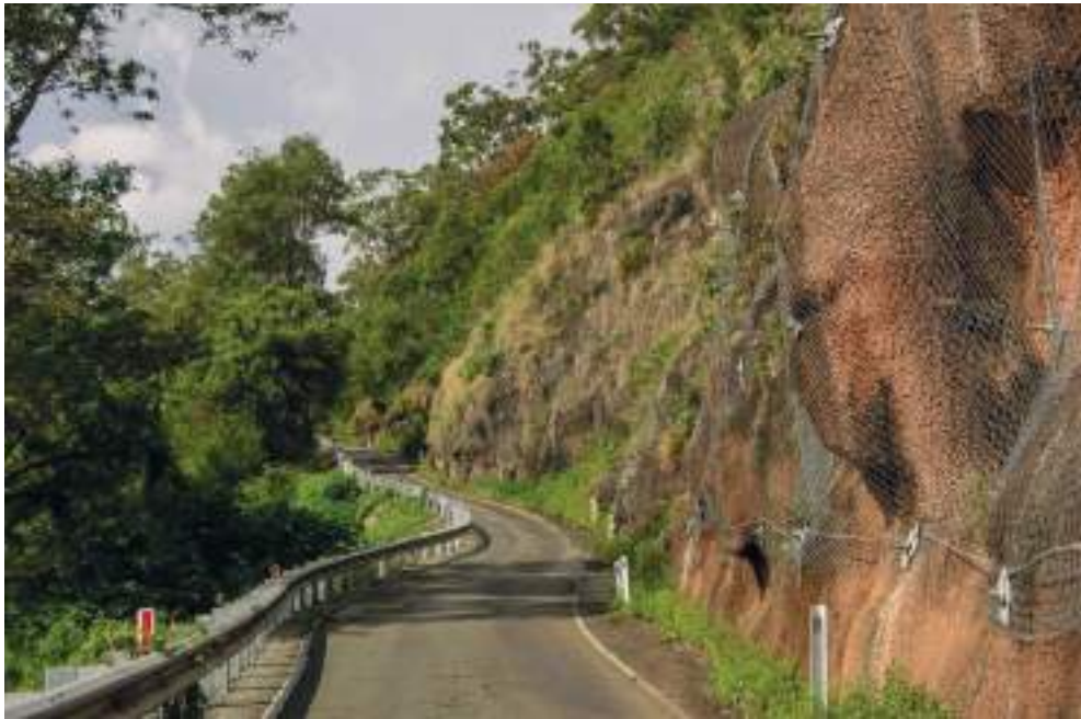
ภาพที่ 6 การติดตั้งตาข่ายกันดินและหินบริเวณที่ลาดเชิงเขา
