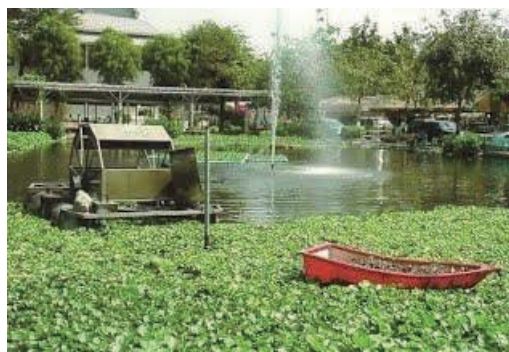
ระบบบำบัดน้ำเสีย
